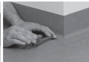
Recorte o revestimento do chão que será colocado. Trabalho concluído sobre o rodapé
